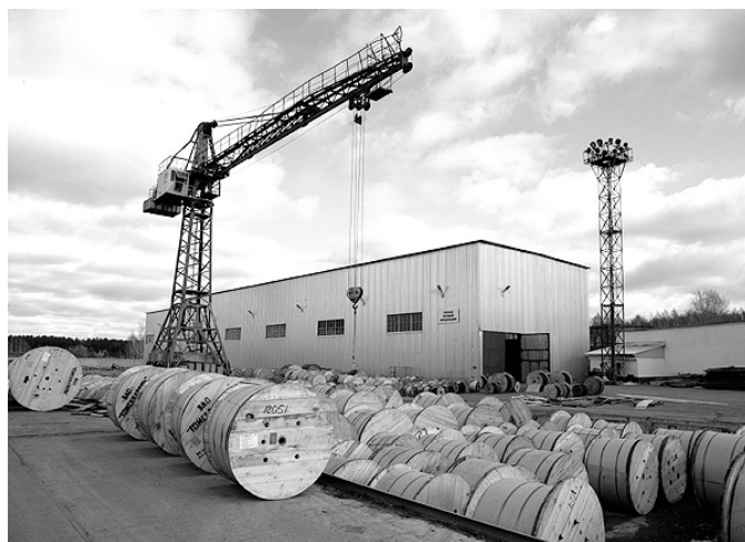
Открытая площадка и склад кабельной продукции
